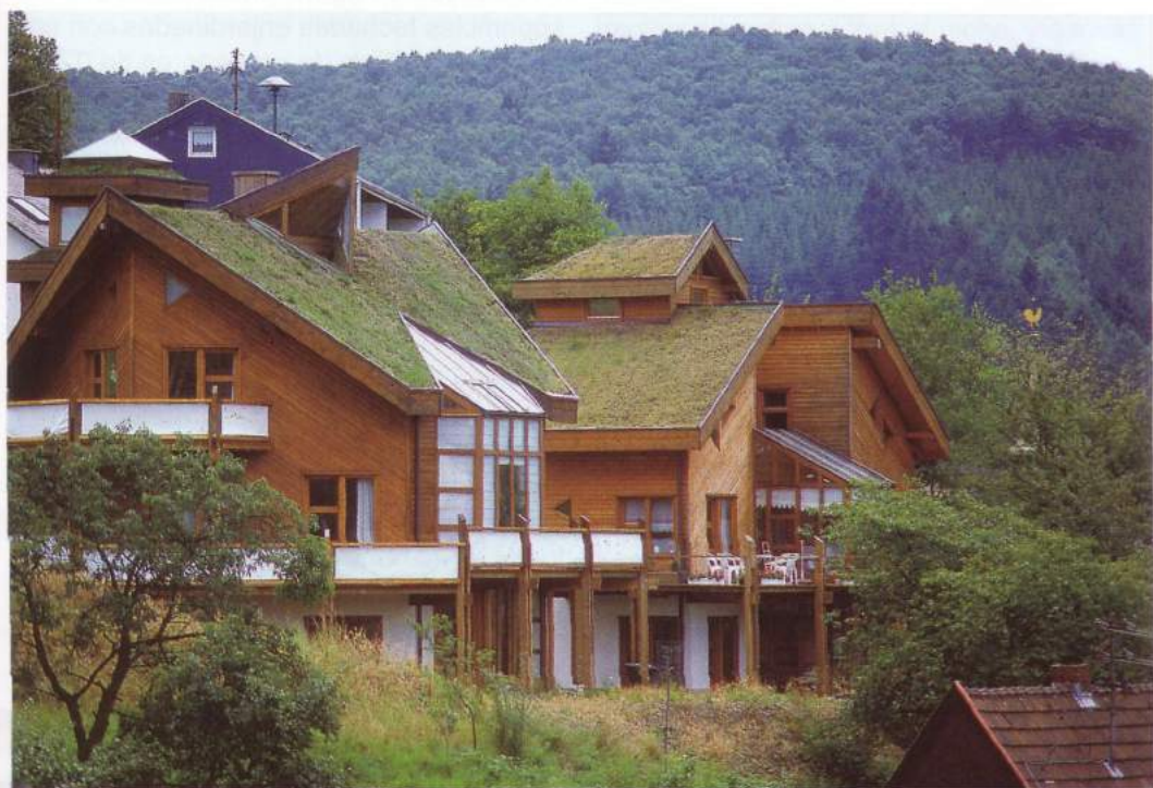
2.10 Techos de césped con 45° de inclinación, Siegen-Oberscheiden (Alemania)
