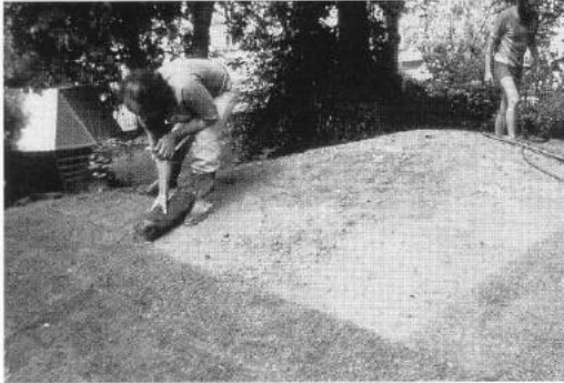
4.9, 4.10 Montaje de césped en rollo
