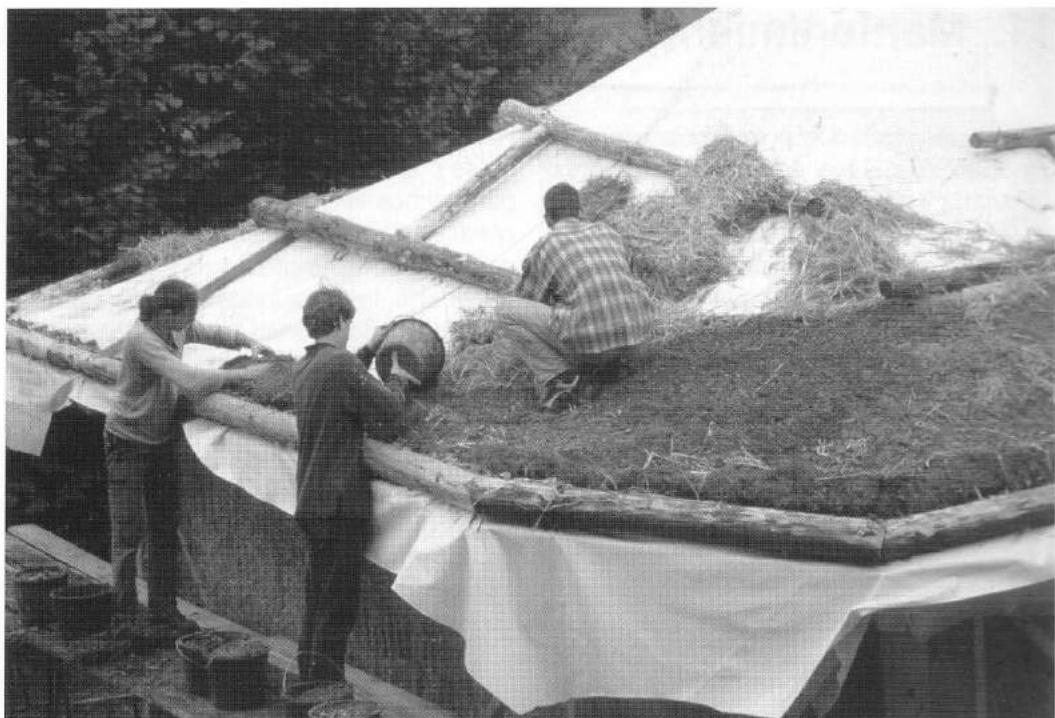
10.6 Montaje de sustrato
