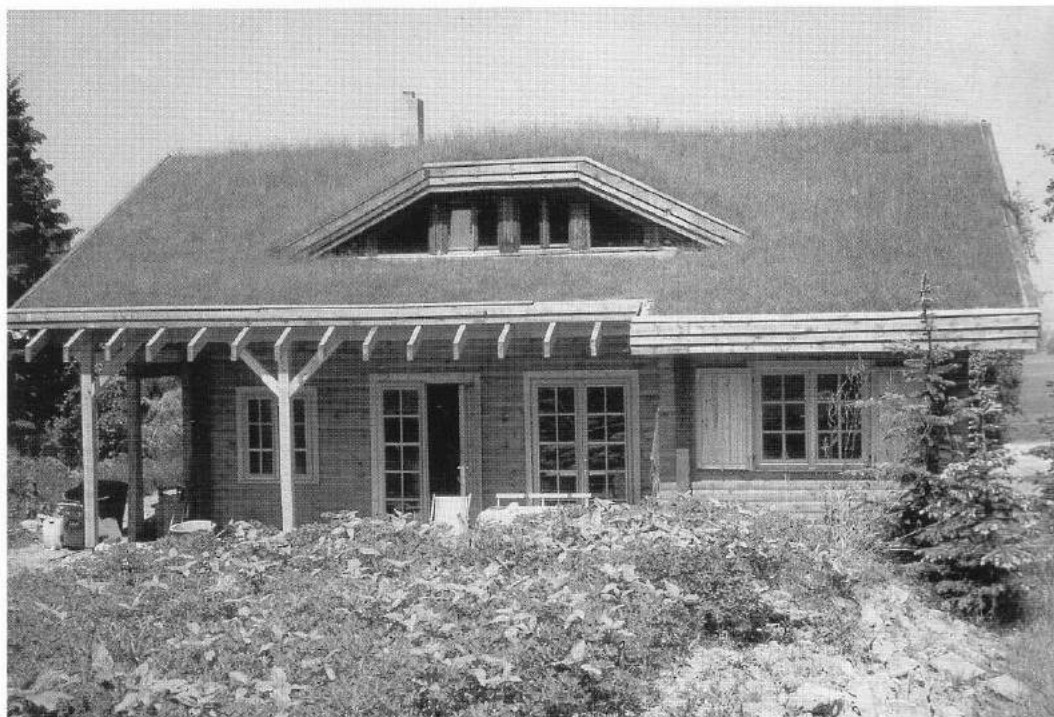
12.1 Techo de césped con lucarna integrada
